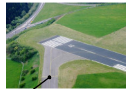
Einbaort der Sensoren bei Rollhalt 27 am Flughafen Saarbrücken-Ensheim
